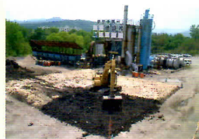
油が含まれた土壌の改良
