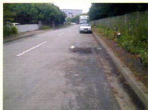
違法駐車車両からの油漏れ。舗装面にオイルが飛散している状況。
